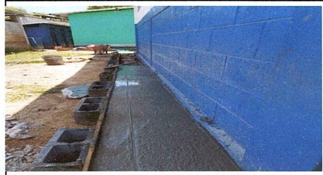
Foto 4: colocación de banquetas
