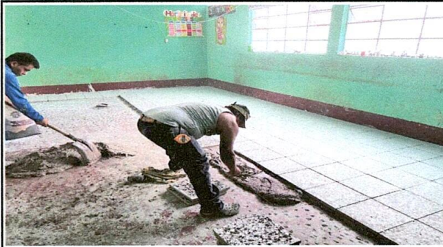
Foto 3: colocación de piso de granito
