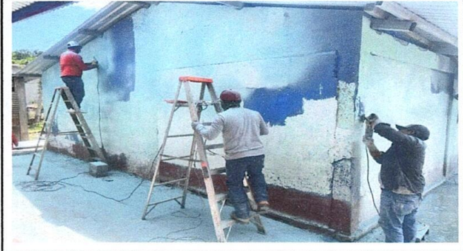
Foto 2: Limpieza en muros exteriores
