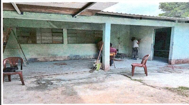
Foto1: Demolición de piso
