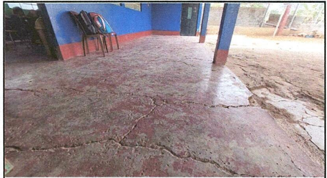
Foto 2: Sustitución de piso exterior e interior con piso de granito.
