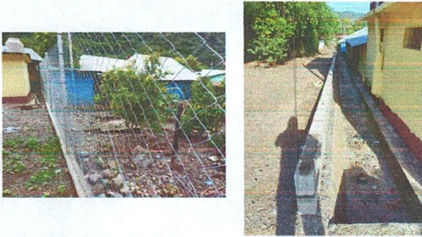
3. REPARACIÓN DE MURO PERIMETRAL
