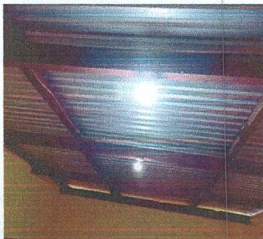
FOTO 5. REPARACIÓN DEL SISTEMA ELÉCTRICO
