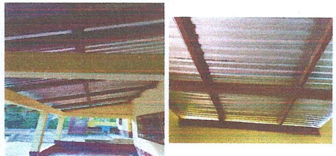
FOTO 4. REPARACIÓN DE ESTRUCTURA DE TECHO
