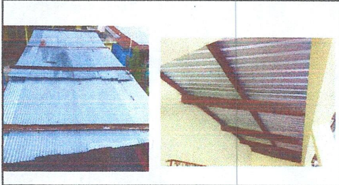
FOTO 1. SUSTITUCIÓN DE CUBIERTA DE LÁMINA
