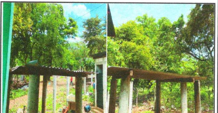
Foto 6: Sustitución de estructura de soporte de madera
