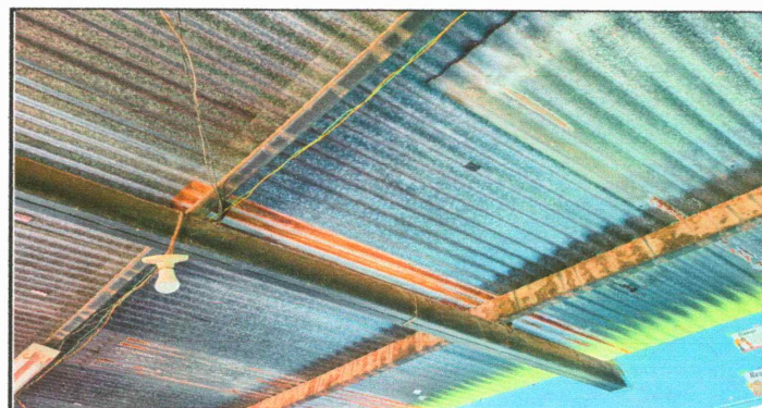
Foto 4: lamina sobre puesta para cubrir agujero
