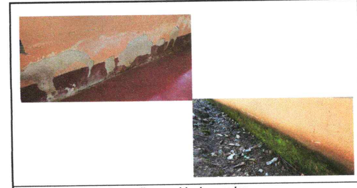
Foto 6: Reparación de repello y cenido de paredes
