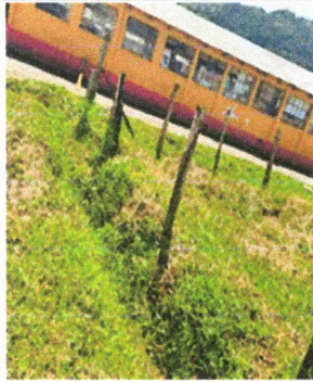
Foto 3: REPARACIÓN DE MURO PERIMETRAL CON TUBO HG Y MALLA
