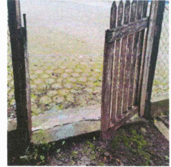
Foto 2: SUSTITUCIÓN DE PORTON DE MADERA POR PORTON DE METAL
