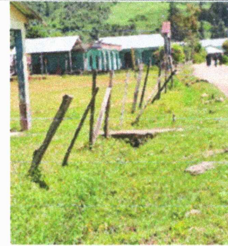
Foto 4: REPARACIÓN DE MURO PERIMETRAL CON TUBO HG Y MALLA
