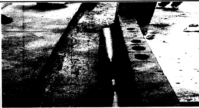
Foto 3: Drenaje en mal estado.
