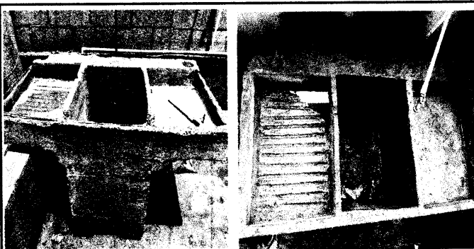
Foto 5: Pila en malas condiciones.
