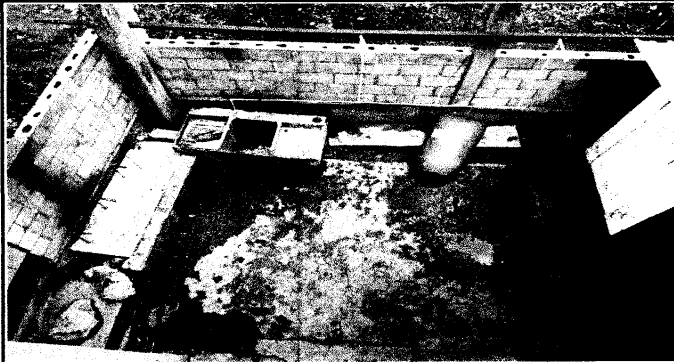
Foto 7: Piso en malas condiciones.
