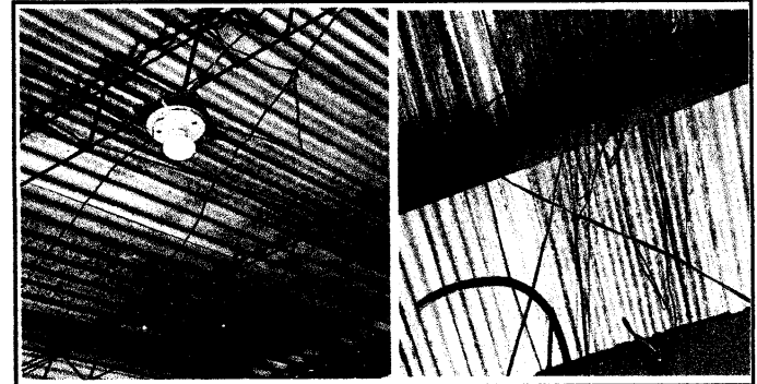
Foto 6: Sistema eléctrico en malas condiciones.
