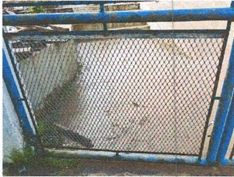
Foto 3: Mantenimiento a portones de metal.
