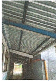
Foto 1: Sustitución de canal de pvc con soportes y accesorios.
