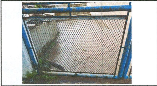
Foto 3: Mantenimiento a portones de metal.
