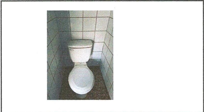
Foto 2: Sustitucion de inodoror
