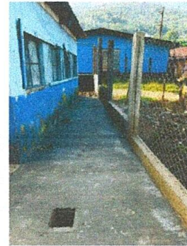
Foto 4: Reparación de planchas de concreto de patio.
