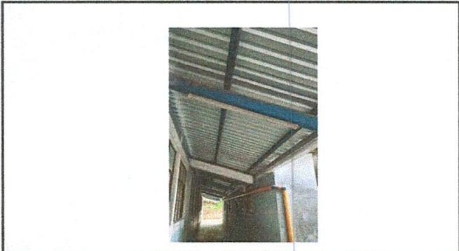
Foto 1: Sustitución de canal de pvc con soportes y accesorios.
