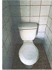
Foto 2: Sustitucion de inodoror
