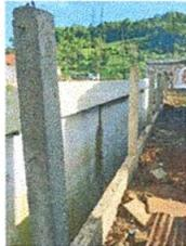
Fot 5: Reparación de muro perimetral con block.
