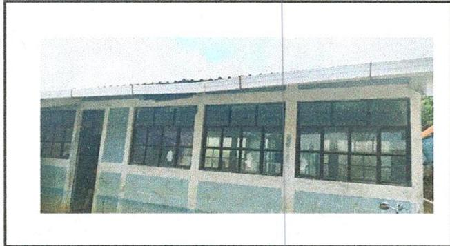
Foto 1: Sustrucción de canal de pvc con soportes y accesorios.
