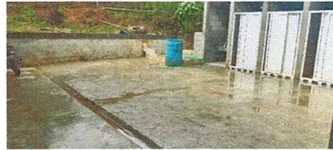
Foto 4: Reparación de planchas de concreto de patio.
