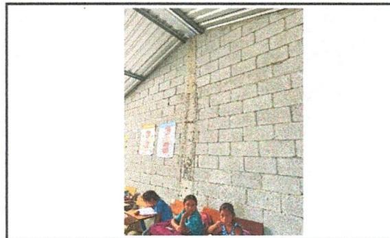
Foto 6: Sellado de grietas y fisuras en muros
