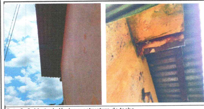
Foto 5: Cubierta de lámina y estructura de techo
