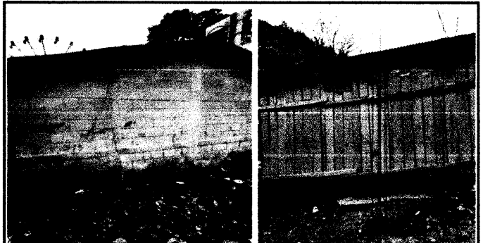
Foto 6: Muro perimetral en malas condiciones
