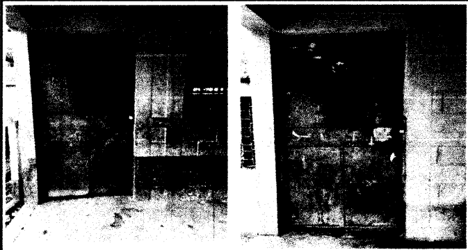
Foto 3: Puertas en malas condiciones
