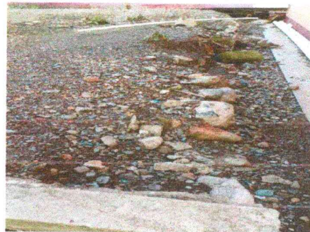
Foto 6. Reparación de muro de contención
