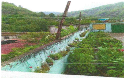
Foto 3. Reparación y pintado de muro perimetral
