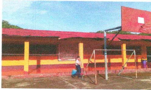
Foto 1. Sustitución de lámina en mal estado por lámina troquelada
