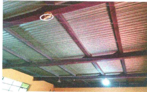
Foto 4. Sustitución de estructura de madera por estructura de metal.
