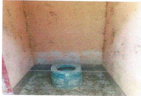
Foto 2. Sustitución de inodoros de cemento por tazas
