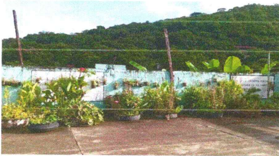
Foto 5. Pintura de muro perimetral
