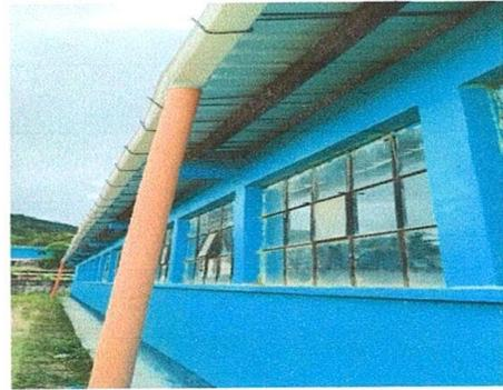
Foto 2: Canal de PVC instalados
