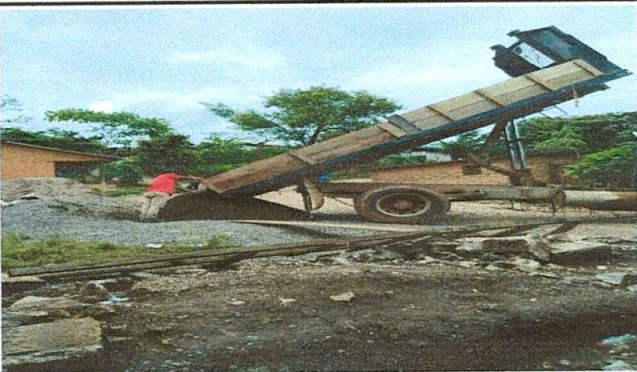
Foto 3: Recepción de materiales
