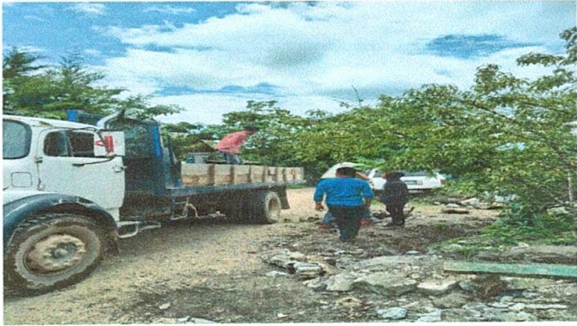
Foto 1: Recepción de materiales
