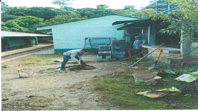
Foto 7: Inicio de trabajo
