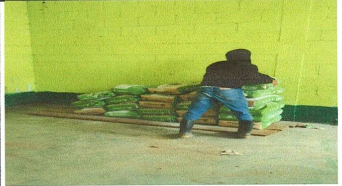
Foto 2: Recepción de materiales
