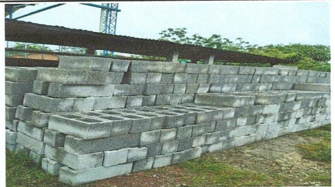
Foto 4: Recepción de materiales
