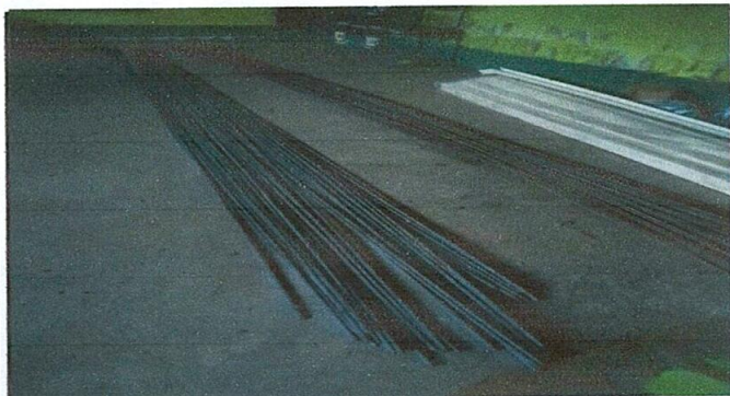
Foto 5: Recepción de materiales
