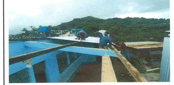
Foto 12: Cambio de techo de lámina
