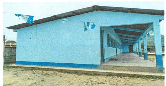
Foto 6 Pintura en muros exteriores e interiores.
