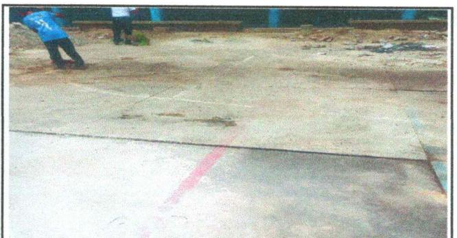
Foto 6: Lozas levantadas y pintura de líneas de marcaje deterioradas en cancha polideportiva
