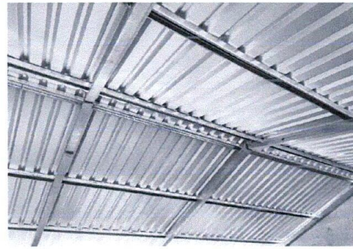
Foto 2: sustitución de estructura de soporte
