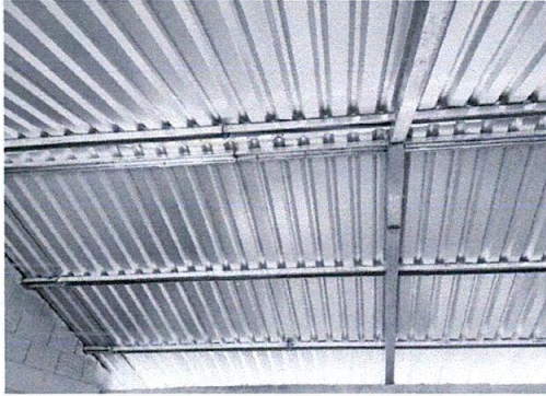
Foto 1: sustitución de lámina por lámina troquelada calibre 26
