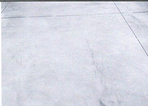
Foto 5: sustitución de piso de torta
