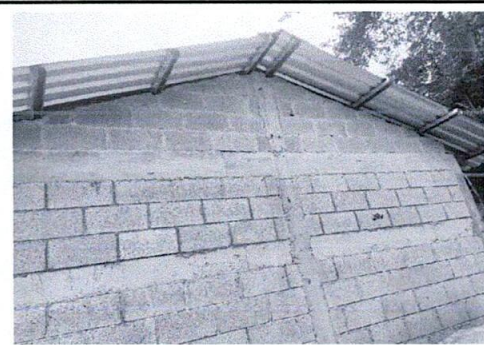
Foto 6: reparación de pared
