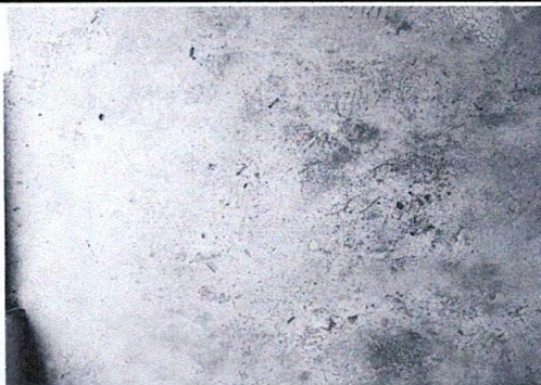
Foto 5: sustitución de piso de torta
