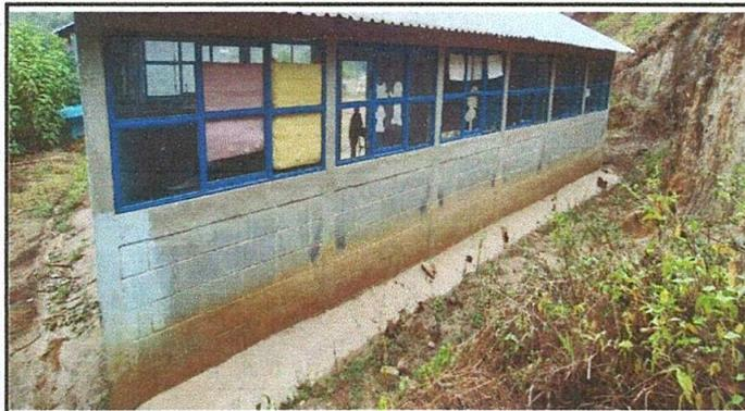
Foto 3: Muro perimetral en malas condiciones.
