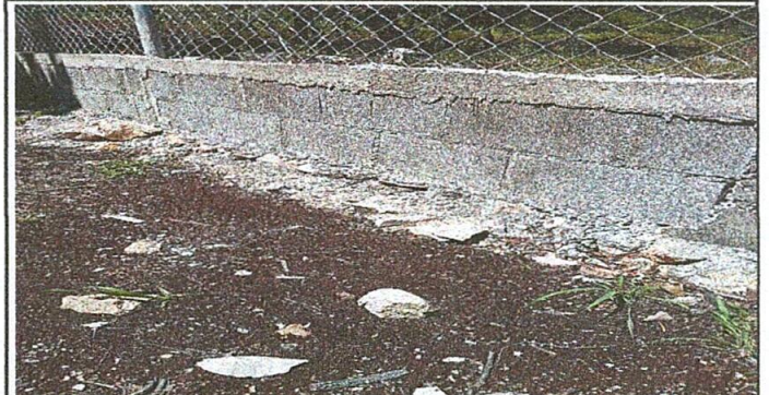
Foto 2: Muro primetral con cimiento de piedra y dos lladas de block.
