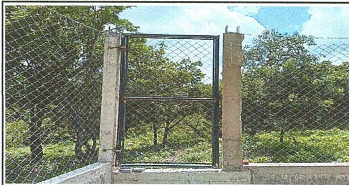
Foto 5: Puerta de emergencia instalada y terminada.
