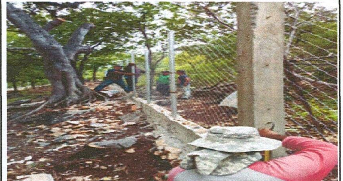
Foto 2: colocación de la maya del predio del muro perimetral
