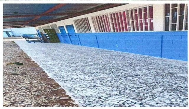
Foto 2: Sustitución de piso de granito
