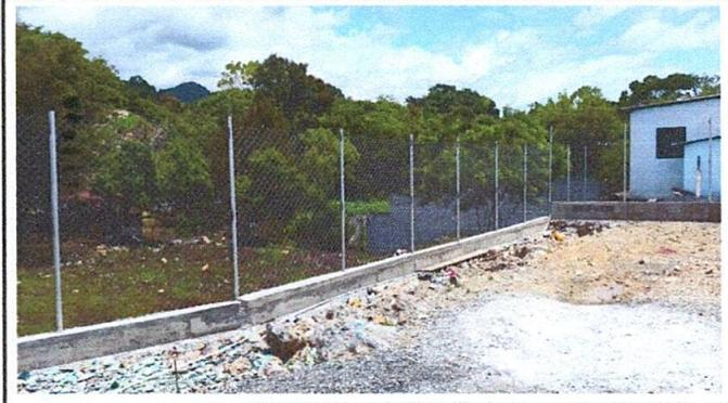
Foto 8: Reparación de Muro de Contención
