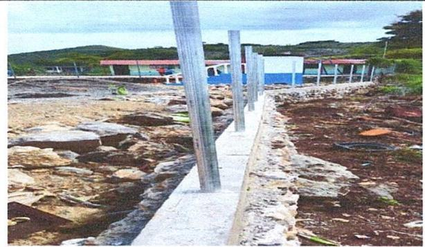
Foto 8: Reparación de Muro de Contención
