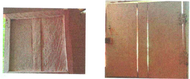
Foto 2: Sustitución de ventana de madera por metal mas vidrio
