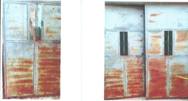
Foto1: Sustitución de puertas y portón de metal
