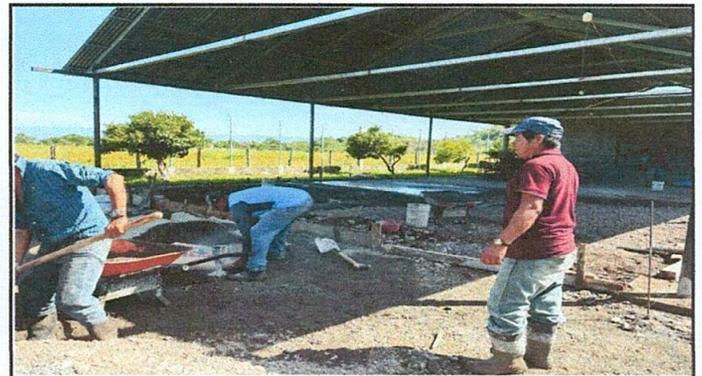
FOTO4: SUSTITUCIÓN DE PISO DE CONCRETO
