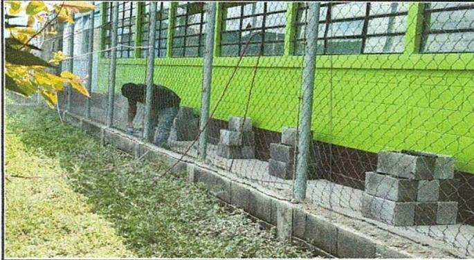
FOTO 7: REPARACIÓN DE MURO PERIMETRAL DE BLOCK
