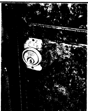
Foto 4: Reparación de puerta
