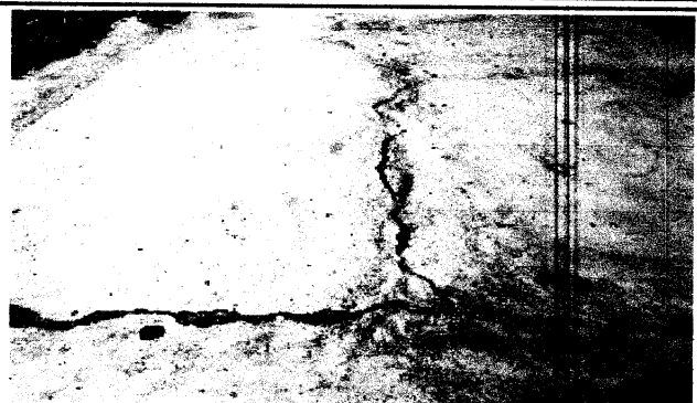
Foto 2: Sustrucción de piso de concreto
