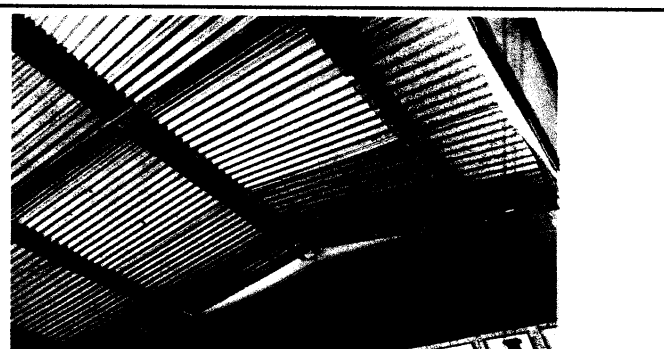
Foto 6: Sustrucción de estructura de techo
