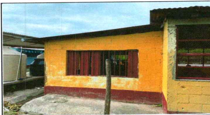
FOTO 15: EN ESTOS DOS AMBIENTES SE INCREMENTARÁ LA ALTURA DE MOJINETES Y DE PAREDES PARA QUE TODA LA ESTRUCTURA DE SOPORTE DE METAL Y DE LAMINA QUEDEN AL MISMO NIVEL Y EN LA MISMA POSICIÓN
