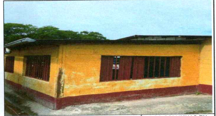
FOTO 16: EN ESTE AMBIENTE SE CONSTRUIRÁN DOS COLUMNAS EN LAS ESQUINAS PRINCIPALES Y UNA VIGA SUPERIOR SOBRE LOS TRES LADOS DE PARED.
