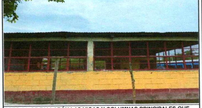
FOTO 14: SE TALLARÁN LAS VIGAS Y COLUMNAS PRINCIPALES QUE EXISTEN ACTUALMENTE
