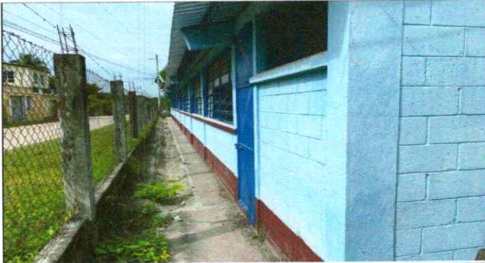
FOTO 7: MUROS EXTERIORES E INTERIORES DE CINCO AULAS Y UNA BODEGA A LOS QUE SE LES APLICARÁ PINTURA
