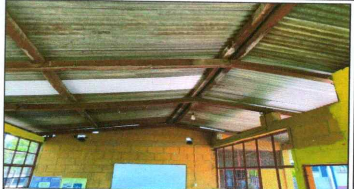
FOTO 2: ESTRUCTURA DE MADERA DETERIORADA, LA QUE SERÁ SUSTITUIDA POR ESTRUCTURA DE METAL
