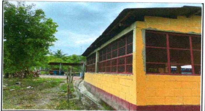
FOTO 4: VENTANAS A LAS QUE SE LES DARÁ MANTENIMIENTO, LIJADO Y APLICACIÓN DE PINTURA
