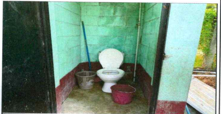
FOTO 6: PISO DE CEMENTO EN LOS SERVICIOS SANITARIOS SOBRE EL CUAL SE COLOCARÁ PISO CERÁMICO.
