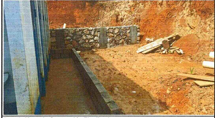
Foto 2: Muro de Contención Finalizado
