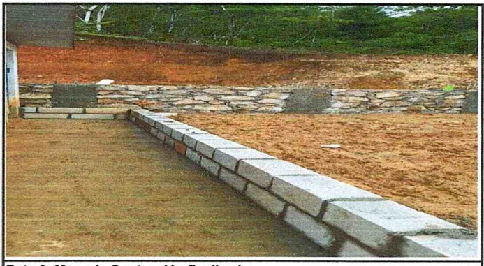
Foto 6: Muro de Contención finalizado
