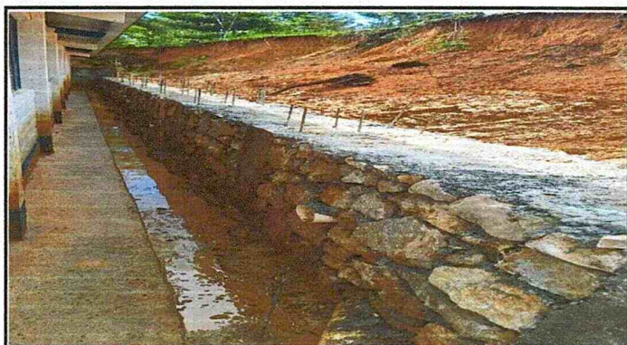
Foto 3: Muro de contención finalizado
