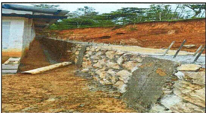
Foto 4: Muro de Contención finalizado
