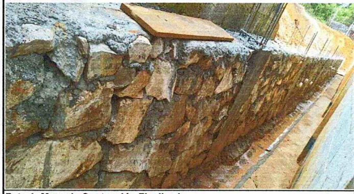
Foto 1: Muro de Contención Finalizado
