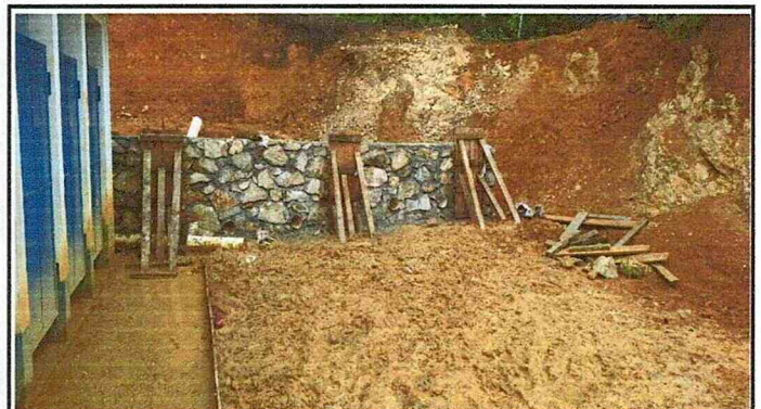
Foto 4: Muro de contención en proceso
