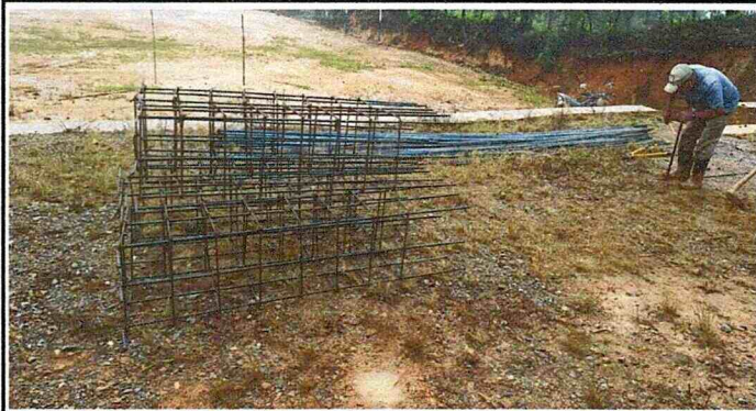
Foto 1. Muro de Contención en proceso.
