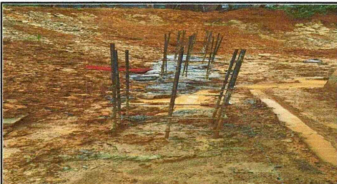
Foto 3: Muro de Contención en proceso
