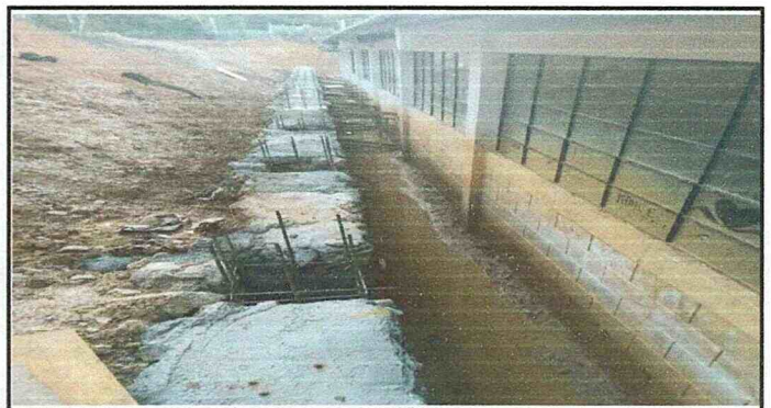
Foto 6: Muro de Contención en proceso
