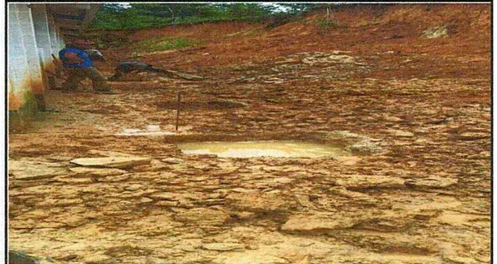
Foto 2: Muro de Contención en Proceso
