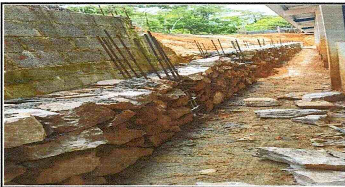
Foto 5: Muro de Contención en proceso
