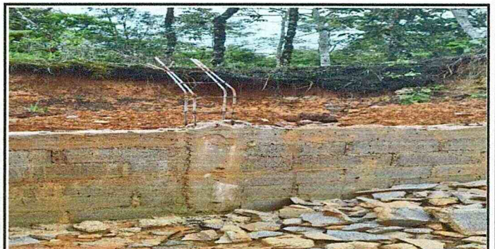
Foto 6: Muro de Contención en malas condiciones.
