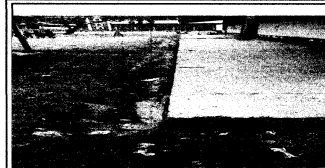
Foto 7. Cuneta de concreto.
