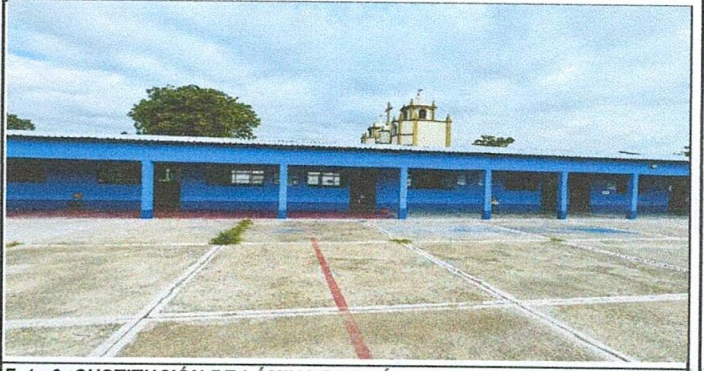
Foto 6: SUSTITUCIÓN DE LÁMINA POR LÁMINA TROQUELADA CALIBRE 26 EN 5 AULAS Y LA DIRECCIÓN DEL CENTRO EDUCATIVO.
