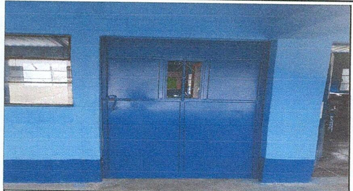
Foto 2: LIJADO Y PINTARA DE PUERTAS CON PINTURA CELCO R-15 SECADO RÁPIDO ANTICORROSIVA
