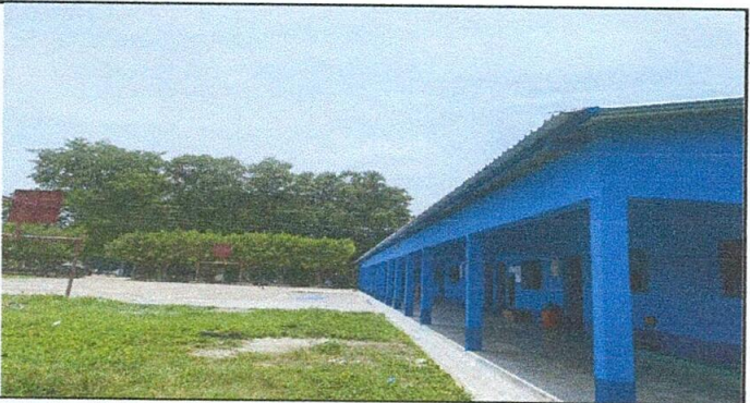
Foto 5: MEJORAMIENTO DE MUROS: SE INCREMENTÓ LA ALTURA DE LAS PAREDES EN 5 AULAS Y LA DIRECCIÓN DEL CENTRO EDUCATIVO.
