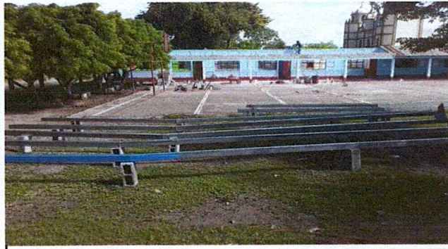
Foto 3: LIJADO Y PINTDO DE ESTRUCTURA DE METAL PARA EL TECHO
