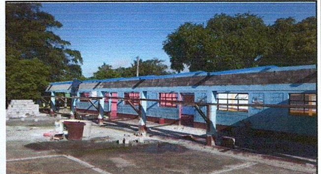
Foto 4: COLOCACIÓN DE ESTRUCTURA DE METAL
