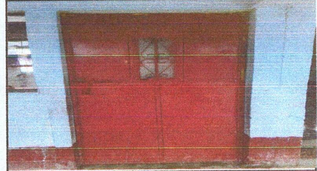
FOTO 4: se dará mantenimiento a 6 puertas de metal: lijado y pintado con pintura anticorrosiva de color azul
