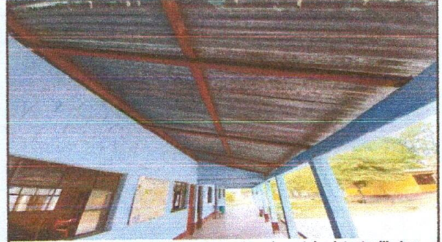
FOTO 2: se dará mantenimiento a estructura de metal existente: lijado y pintado de montones con pintura anticorrosiva en dos aulas y la Dirección del centro educativo
