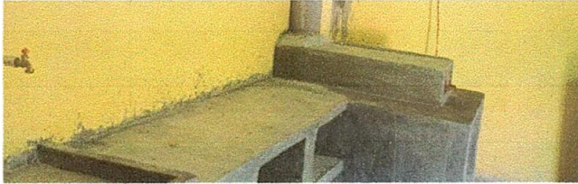
Foto1: SUSTITUCIÓN DE PLANCHA DE 3 HORNILLAS
