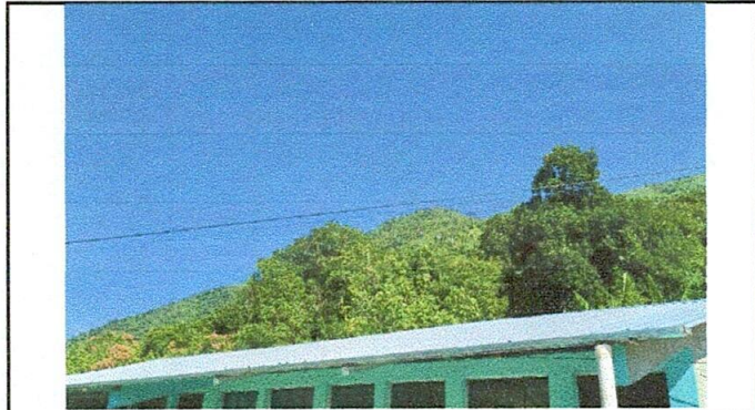
Foto1: CUBIERTA DE LÁMINA
