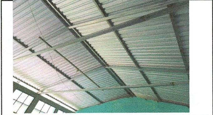
Foto 2: ESTRUCTURA DE TECHO
