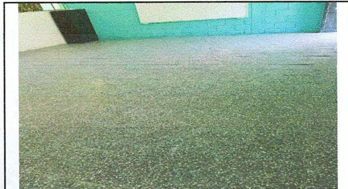
Foto 3: SUSTITUCIÓN DE PISO DE GRANITO
