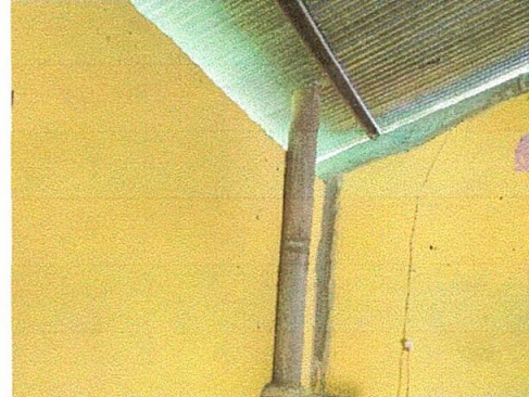
Foto 2: SUSTITUCIÓN DE CHIMENEA DE CONCRETO
