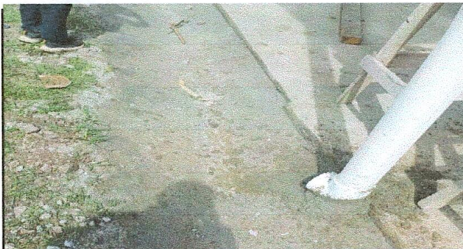
Foto 5: CUNETETA DE CONCRETO
