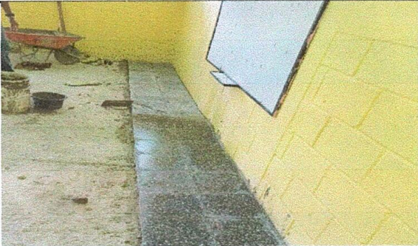
Foto 3: SUSTITUCIÓN DE PISO DE GRANITO
