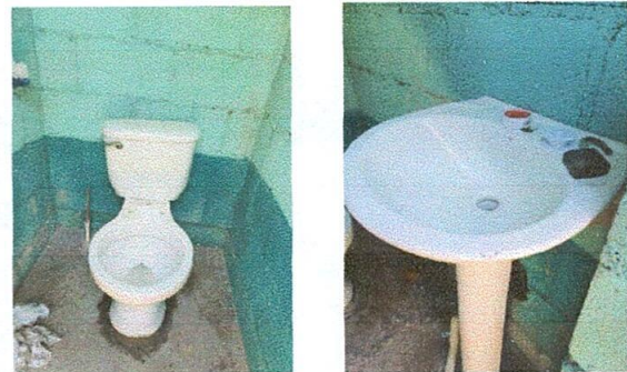
Foto 6: SUSTITUCIÓN DE SANITARIOS Y LAVAMANOS
