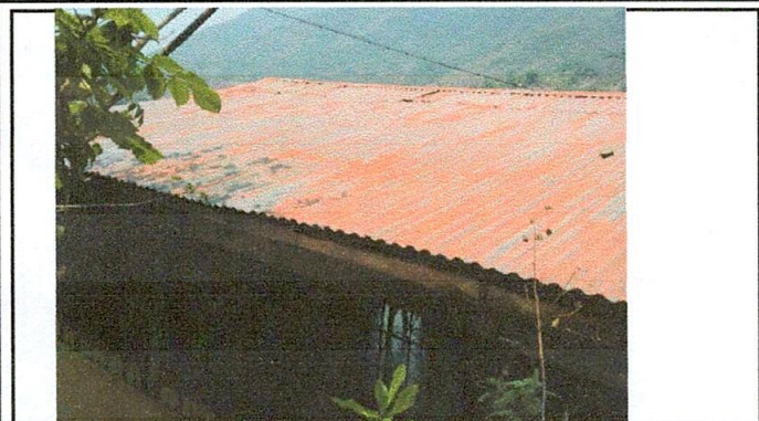
FOTO 1: CUBIERTA DE LÁMINA
