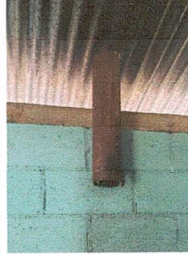
FOTO 8: SUSTITUCIÓN CHIMENEA DE CONCRETO
