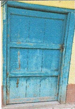
FOTO 9: SUSTITUCIÓN DE PUERTA DE MADERA POR PUERTA DE METAL
