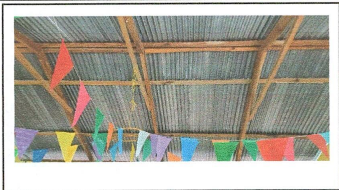
FOTO 2: ESTRUCTURA DE TECHO
