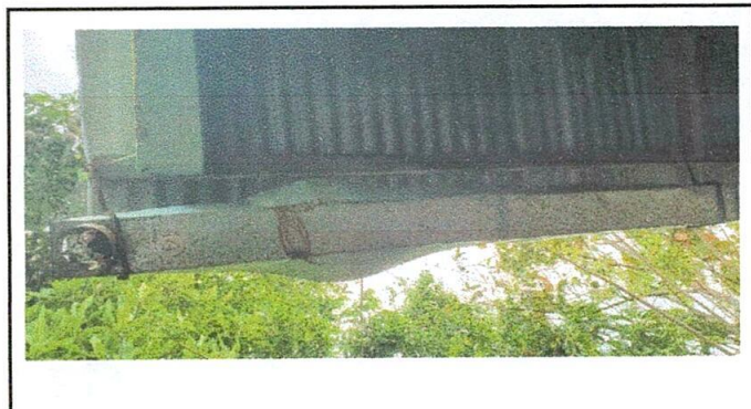
FOTO 4: CANALES Y BAJADAS DE AGUA PLUVIAL
