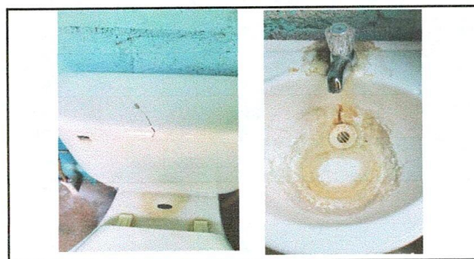
FOTO 6: SUSTITUCIÓN SANITARIOS Y LAVAMANOS
