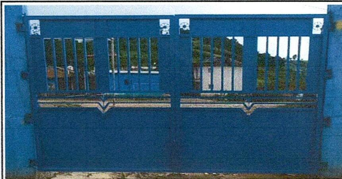
Foto 5: Mejoramiento de porton de metal de ingreso
