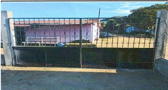
Foto 3: sustitución de estructura de soporte
