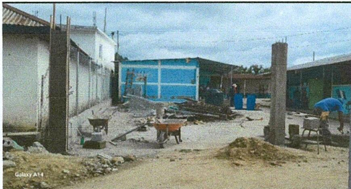
Foto 3: sustitución de estructura de soporte
