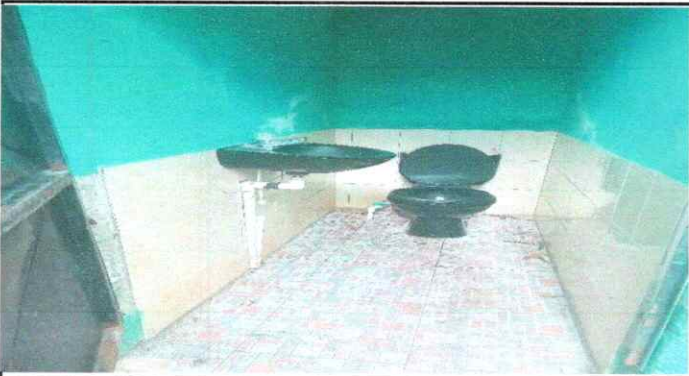
Foto 3: Sustitucion de accesorios
