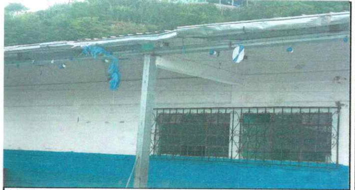
Foto 2: Ventanas, canales y pintura
