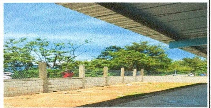
Foto 2: Sustitución de muro perimetral
