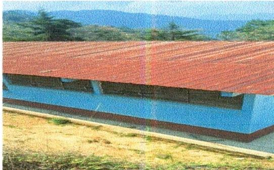
Foto. 1: Sustitución de lámina troquelada
