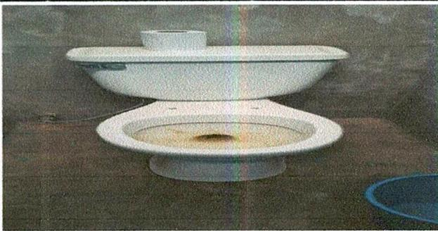
foto 5: sustitución completa de tazas sanitarias
