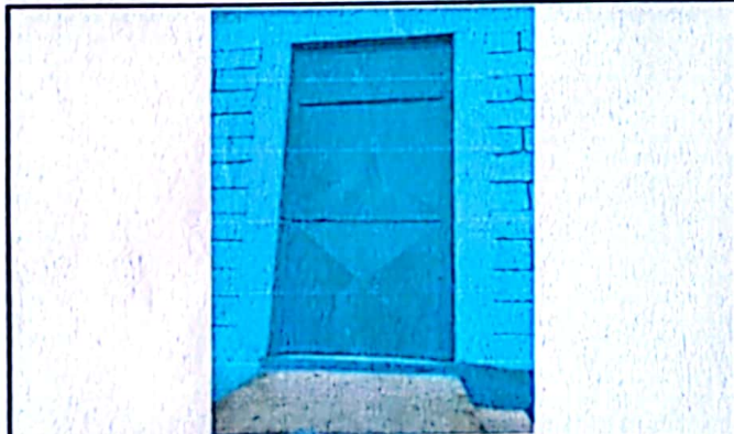
Foto 3: mantenimiento a puertas de metal
