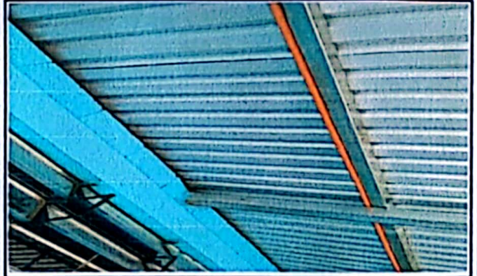
Foto 2: estructura de techo
