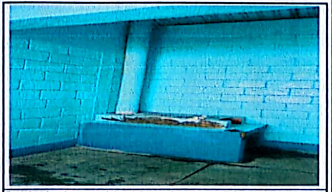
Foto 6: plancha y pared de cocina en buenas condiciones.
