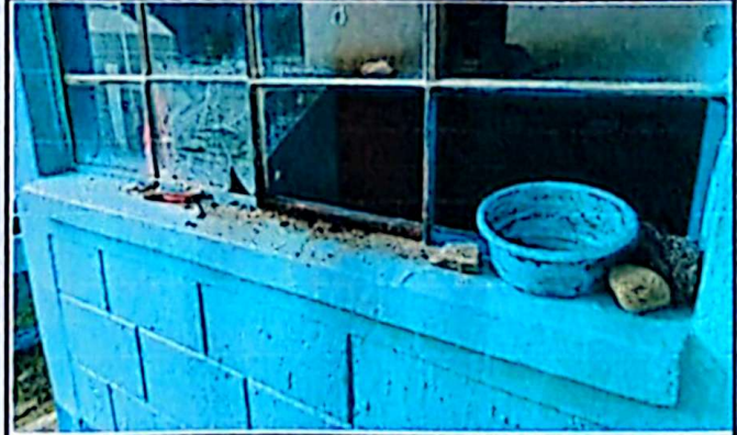
Foto 4: mantenimiento y sustitución de vidrios de ventanas
