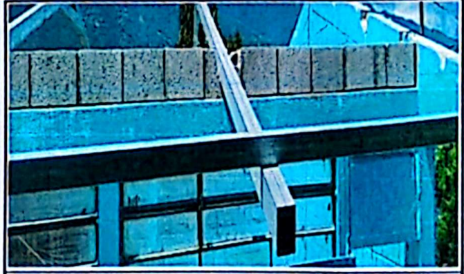
Foto 2: estructura de techo
