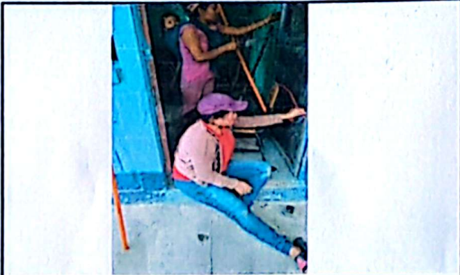
Foto 3: mantenimiento a puertas de metal
