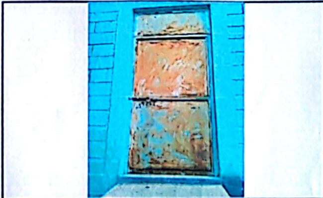
Foto 3: mantenimiento a puertas de metal
