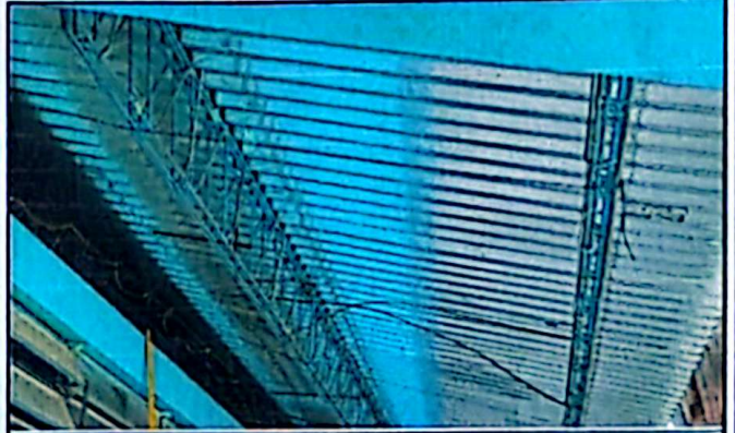
Foto 2: estructura de techo
