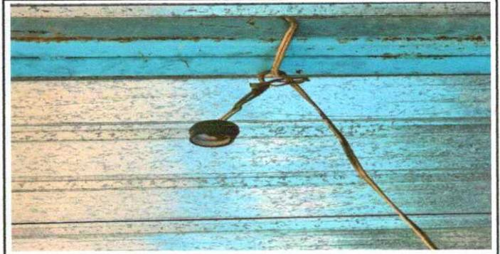
Foto 6: Sistema electrico en mal estado
